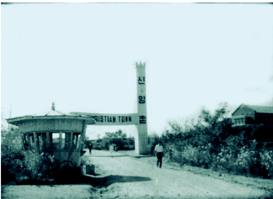
소사신앙촌 출입구 전경. 지금은 철거되어 볼 수 없다
